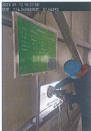
DA047 大颗粒造粒排放口
