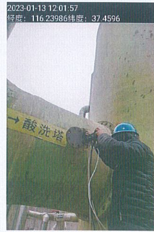
DA116 碳一污水处理设施废气回收进口
