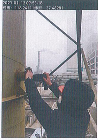
DA099 己二酸污水处理设施废气回收出口
