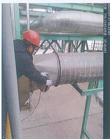
DA133 醋酐危废仓库处理设施进口
