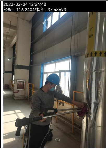
项目切粒系统（切粒干燥） 排气筒 (P3)
