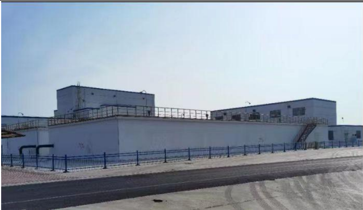
项目依托污水处理站
