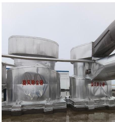
图 4.1-3 干燥工序 2 套旋风除尘器
