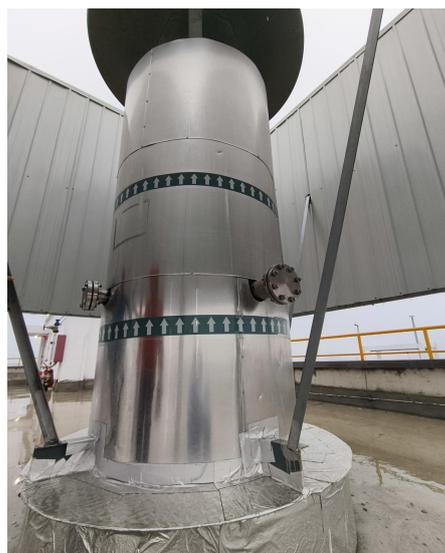
图 4.1-6 干燥工序 1 根 39m 高排气筒 P<sub>2</sub>
