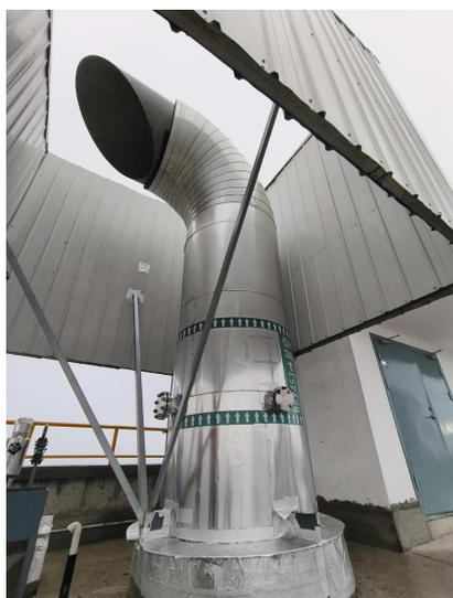
图 4.1-7 干燥工序 1 根 39m 高排气筒 P<sub>3</sub>
