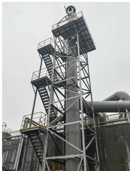
图 4.1-17 结片工序 1 根 33m 高排气筒 P<sub>6</sub> 图 4.1-18 新建污水站 1 根 25m 高排气筒 P<sub>7</sub>
