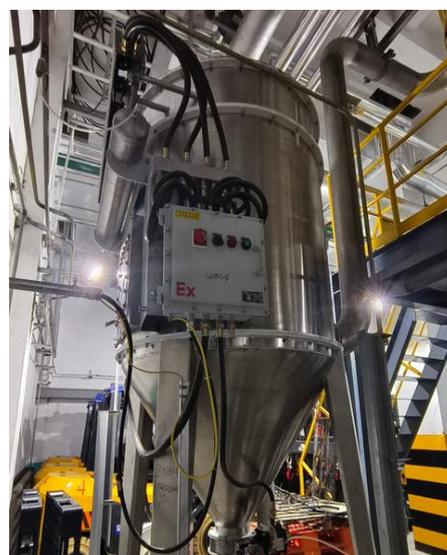
图 4.1-14 二元酸包装废气 3#布袋除尘器
