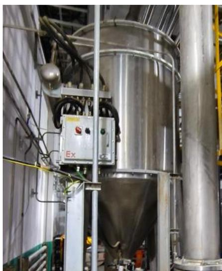
图 4.1-13 二元酸包装废气 2#布袋除尘器
