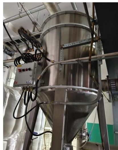
图 4.1-10 己二酸包装废气 3#布袋除尘器
