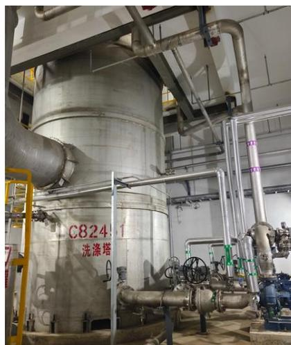
图 4.1-4 干燥工序 1#水洗塔
