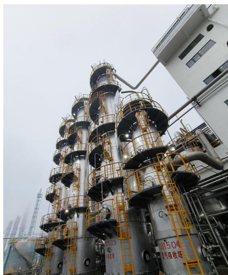
图 4.1-2 “三级水洗+SCR 脱硝”装置+1 根 40 高排气筒 P<sub>1</sub>
