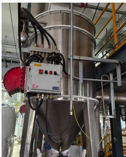
图 4.1-9 己二酸包装废气 2#布袋除尘器
