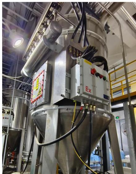
图 4.1-12 二元酸包装废气 1#布袋除尘器
