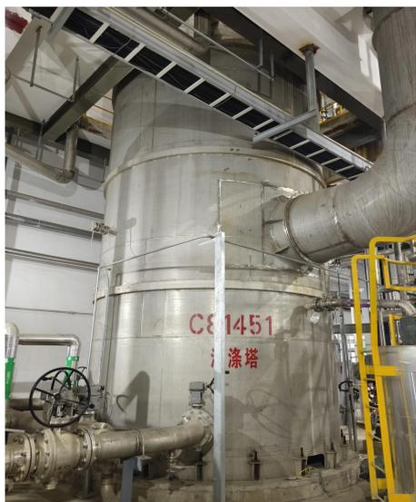
图 4.1-5 干燥工序 2#水洗塔
